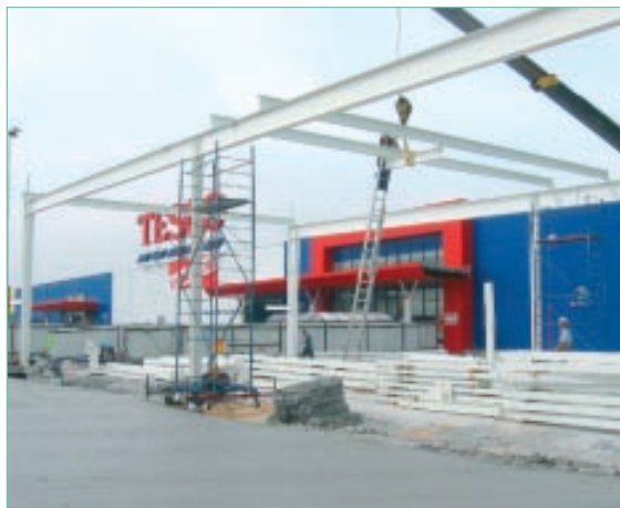
Inwestycja Tesco w Rudzie Śląskiej
